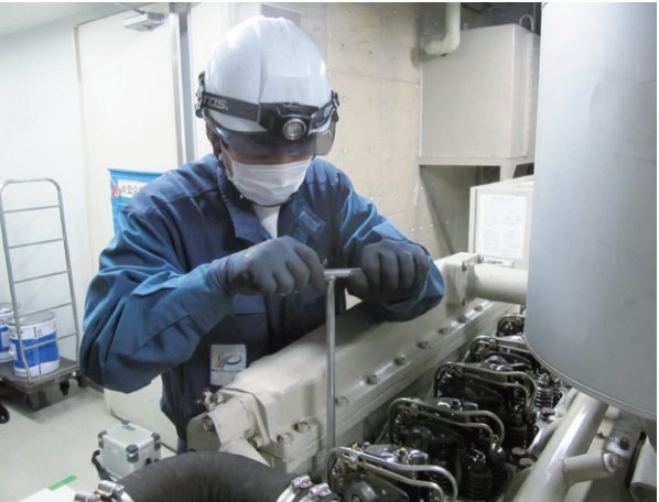
燃料噴射ノズル点検①
