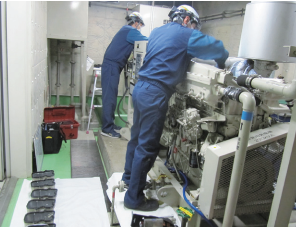
燃料噴射ノズル点検②
