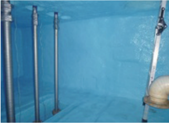
④断熱防水の更新後
