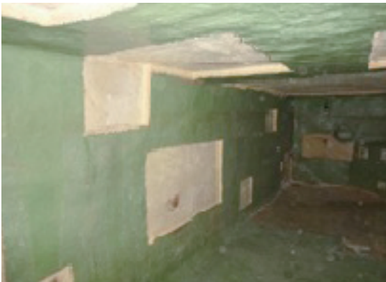
②既設断熱防水の部分撤去
