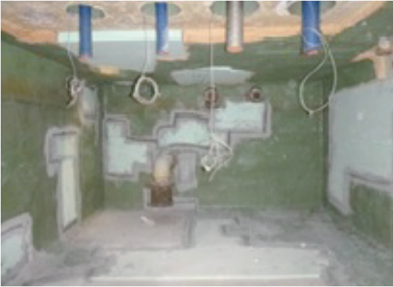
③断熱の部分補修箇所
