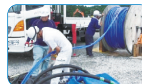
太陽光発電所工事
