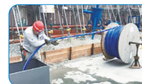
タワークレーン電源工事
