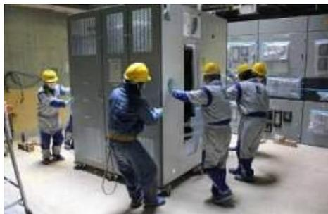
1号機 電源盤 (P/C 1C-1) 据付作業
