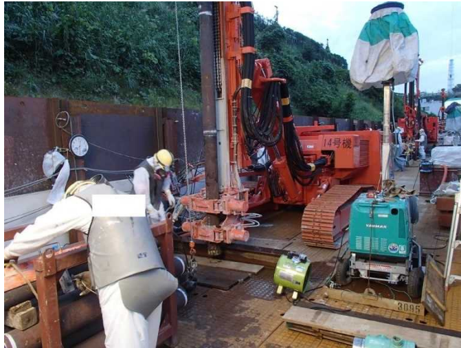
図-4 ボーリング削孔（イメージ）
