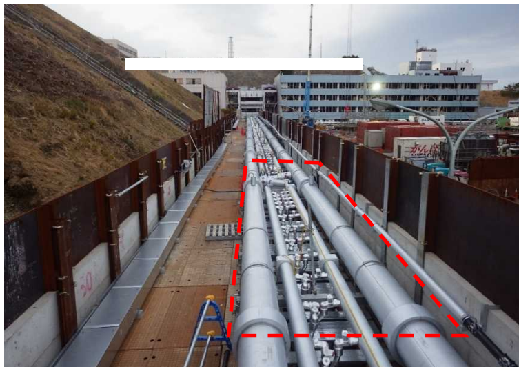
図－3 配管類撤去箇所の例
