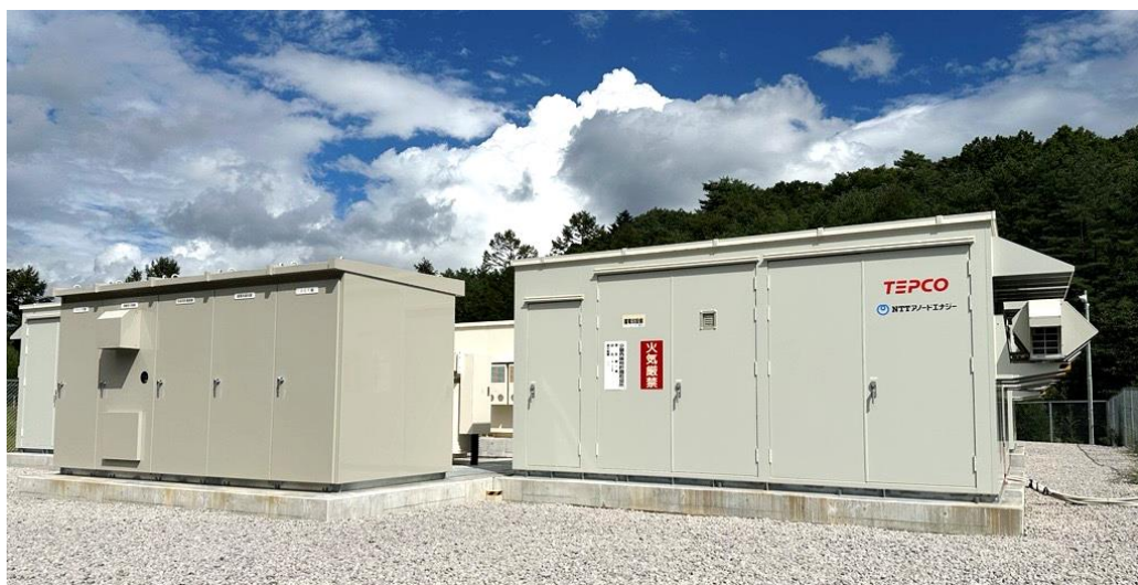
【嬭恋蓄電所 外観】
